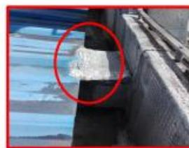
Mantenimiento puertas en vidrio en los principales accesos del hospital, bisagras hidráulicas en mal estado, estas bisagras no predijeron la acumulación de agua cuando se realizan limpieza y desinfección de los servicios, esta agua queda acumulada en las cajas de las bisagras se instalaron y no se recomienda cambio de sistema por algo más práctico y que soporte trabajo pesado.
