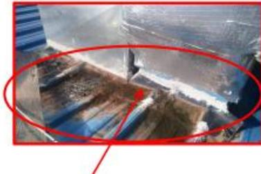
Se evidencia Instalación cinta tapa goteras y aplicación de sellantes
