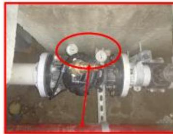
Se evidencia como la válvula regula la presión en la salida y entrada del agua.
