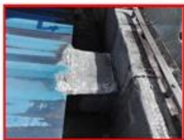
Ajuste viga canal en concreto, en algunos puntos específicos del hospital, el agua se regresa por estos puntos.
