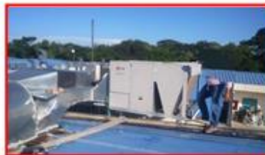
Se evidencia Instalación cinta tapa goteras y aplicación de sellantes
