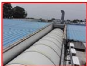
Ajuste cubierta en material policarbonato pasillos internos del hospital.
