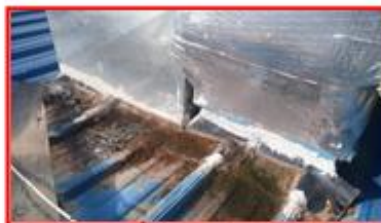
Se evidencia Instalación cinta tapa goteras y aplicación de sellantes
