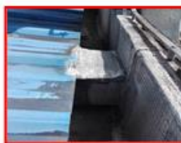
Ajuste viga canal en concreto, en algunos puntos específicos del hospital, el agua se regresa por estos puntos.
