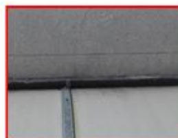
Ajuste viga canal en concreto, en algunos puntos específicos del hospital, el agua se regresa por estos puntos.
