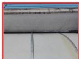
Ajuste viga canal en concreto, en algunos puntos específicos del hospital, el agua se regresa por estos puntos.
