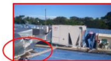
Retiro de ductos galvanizados en pared.
