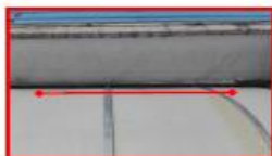
Ajuste viga canal en concreto, en algunos puntos específicos del hospital, el agua se regresa por estos puntos.
