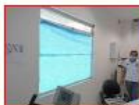
INSTALACIÓN DE POLARIZADO PARA CORTAR LA VISUAL Y MEJORAMIENTO EN LA PRIVACIDAD DEL PACIENTE EN VARIOS PUNTOS DEL HOSPITAL.
