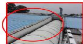
Ajuste cubierta en material policarbonato pasillos internos del hospital.
