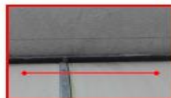
Ajuste viga canal en concreto, en algunos puntos específicos del hospital, el agua se regresa por estos puntos.
