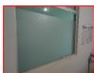
INSTALACIÓN DE POLARIZADO PARA CORTAR LA VISUAL Y MEJORAMIENTO EN LA PRIVACIDAD DEL PACIENTE EN VARIOS PUNTOS DEL HOSPITAL.
